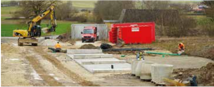
Deutliche Fortschritte im Februar: Zwischen den Fundamenten haben Lehrlinge fachmännisch gepflastert.
