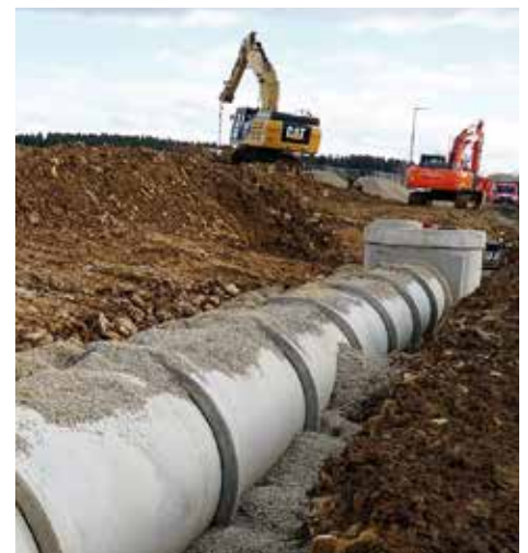
Das Gefälle in einem solchen Kanal muss exakt stimmen.
