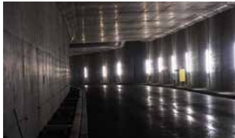
Die Südöhre des Doppeltunnels.
