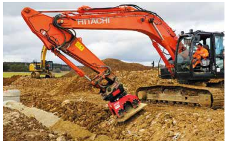
Daniel Höll bei der Bodenverdichtung.
