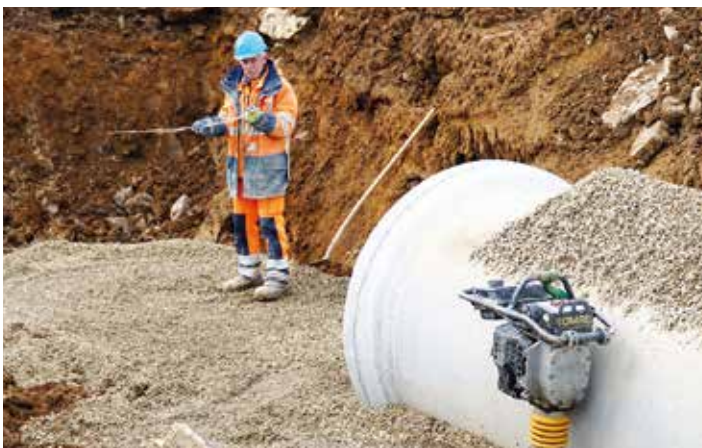
Alexander Knutas wartet auf das nächste Rohrsegment.
