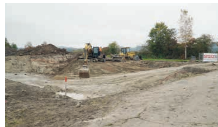
Ein neues, gemeinsames Wasserwerk soll die alten Einrichtungen ergänzen: Storzianer heben die Baugrube aus.
