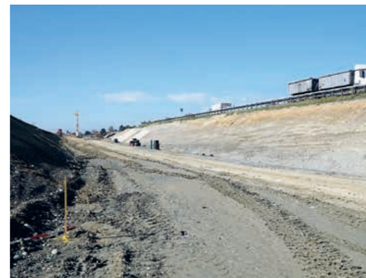
Auf der Nordseite verläuft derzeit noch die aktuelle Bundesstraße, die zurückgebaut werden soll.
