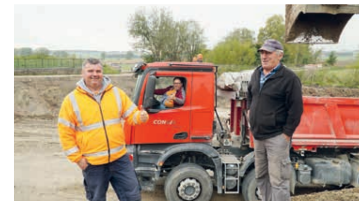
Sie bereiten den Zielpunkt des Leitungsbaus vor (v.l.): Baugeräteführer Igor Golik, CONVIA-Trucker Michael Baum, Raupenfahrer Peter Jorich.
