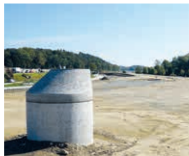
Über den Damm führt dann die provisorische Umleitung der B33. Dazu wird er noch deutlich höher aufgeschüttet.
