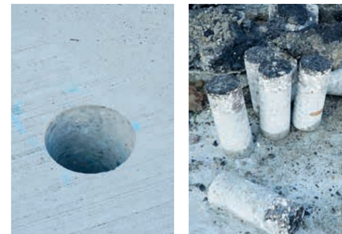
Unter den Verkehrsinseln befinden sich Entwässerungslöcher (l.). Die Bohr-kerne (r.) zeigen den neuen Aufbau der Verkehrsflächen.
