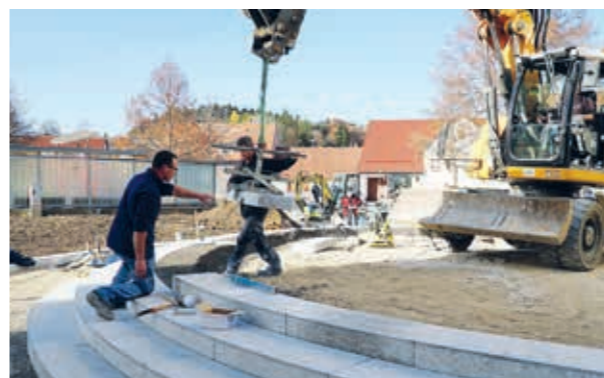
Eine halbrunde Treppenanlage prägt den Vorplatz der Kirche.
