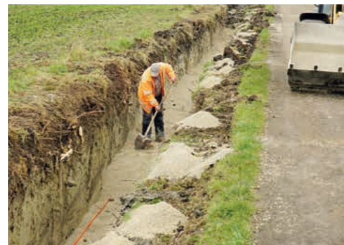
Verlegungstiefe neben dem Wirtschaftsweg: 1,4 m.
