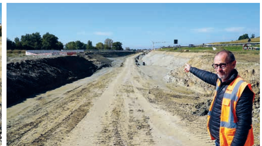
Durch diesen Einschnitt soll später die neue B33 führen. Die schwarzen Entwässerungsschächte liegen in der Mitte der künftigen Bundesstraße.
