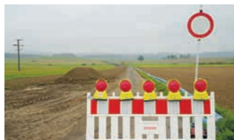
Die Doppelleitung wurde an drei Stellen mit Spülbohrungen durch sumpfiges Gelände geführt.
