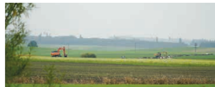
Gegenschuss vom bisherigen Wasserwerk „Schabelwiesen“ aus: Die Leitungsbauer nähern sich.
