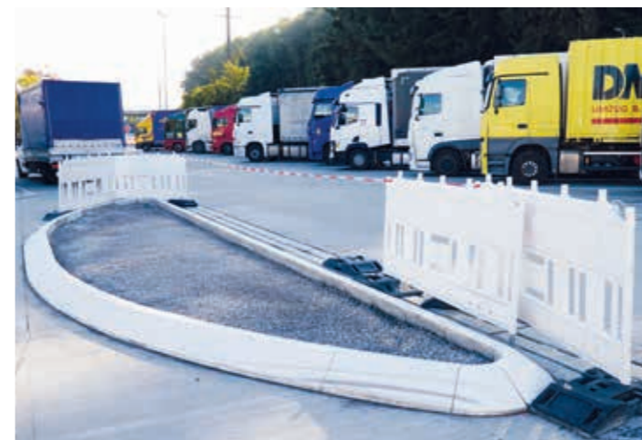
Aufgeklebte Inseln dienen zur Verkehrsführung.
