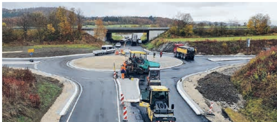
Der neue Kreisverkehr kurz vor seiner Fertigstellung.
