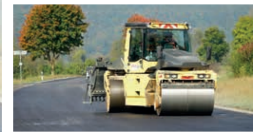
Die Tandemvibrationswalze kann große Flächen in einem Zug glätten, und das im „Hundegang“.
