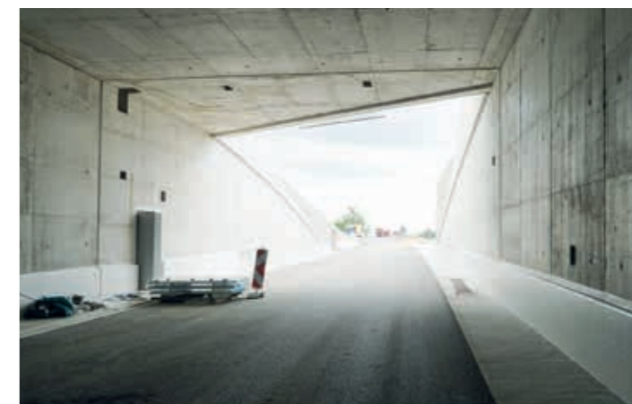
Der Tunnel Waldsiedlung bei Konstanz. Auch hier kam Niedrigtemperaturasphalt zum Einsatz.
