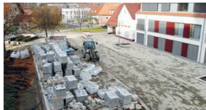
Insgesamt 25 PKW-Stellplätze stehen bald zur Verfügung.
