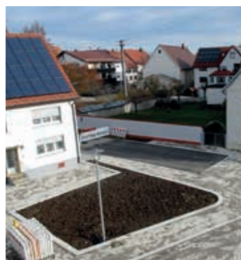
Die bislang asphaltierte Ortsmitte wurde aufwendig gepflastert.
