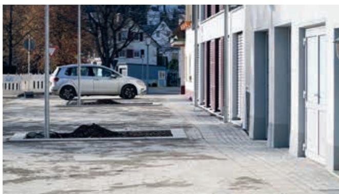
Aus praktischen Gründen wurde Pflaster bis an die Hauswände verlegt.
