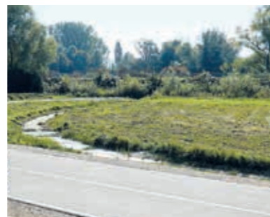
Durch die Auflast des Damms wird der Boden entwässert. Das Wasser fließt in Richtung Bodensee ab.
