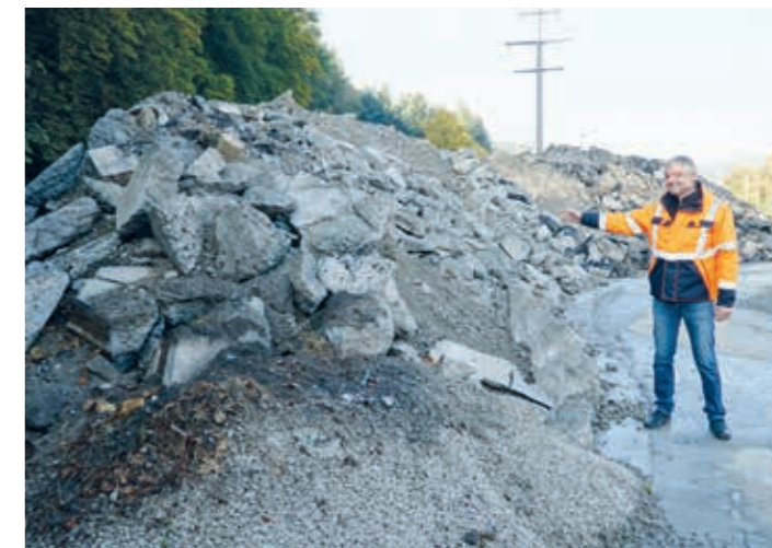
Solcher Betonbruch wurde aufbereitet und wieder eingebaut als Frost-schutzschicht.
