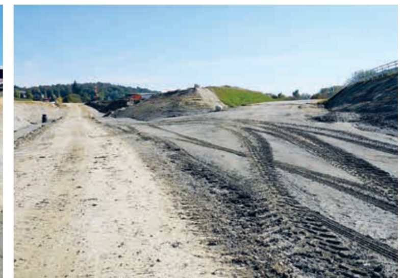
Diese Gabelung zeigt in die Zukunft: Rechts geht es zur provisorischen Umleitung über den Damm, links in das künftige Baufeld für den Tunnel Hegne.
