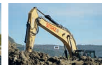
Große Mengen Mutterboden wurden ausgehoben.
