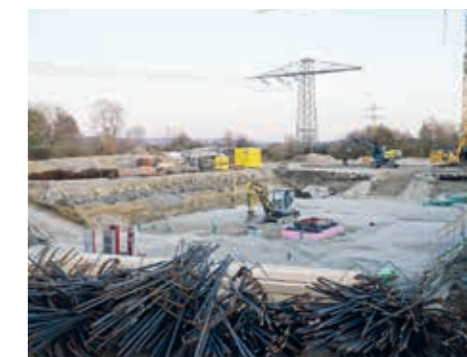
Wenige Wochen später sind die Gründungsarbeiten weit fortgeschritten.
