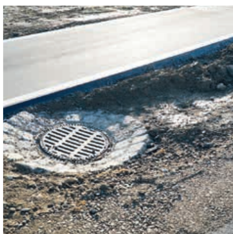
Auch die Straßenentwässerung wurde erneuert.
