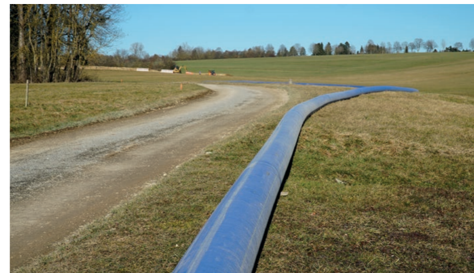
Mehrere hundert Meter der Druckwasserleitung wurden verschweißt und warten auf ihren Einbau.
