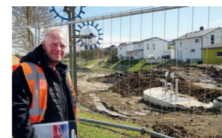
Bauleiter Sven Stutzmann vor der neuen Löschwasserzisterne am ehemaligen Löschwasserloch.
