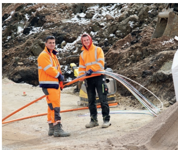
Facharbeiter Silahic Elvedin (l.) und Fachwerker Komsic Drazen verlegen Medienkabel.
