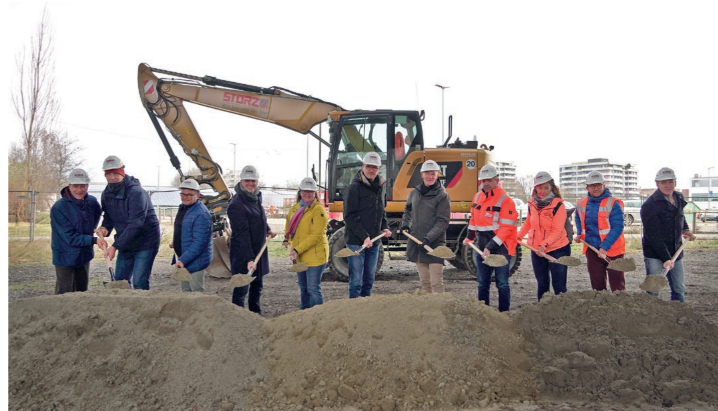
Spatenstich für den neuen Zentralen Omnibusbahnhof in Konstanz: Oberbürgermeister Ulrich Burchardt (M.), Baubürgermeister Karl Langensteiner-Schönborn (5.v.r.), STORZ-Geschäftsführer Markus Eisen (4.v.r.) und STORZ-Bauleiter Josua Grothaus (2.v.r.).
