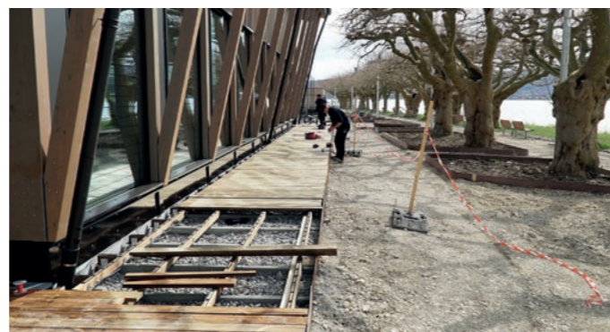
Zimmerleute legen im Auftrag von Schöppler das Holzdeck rund ums Gastronomiegebäude an.
