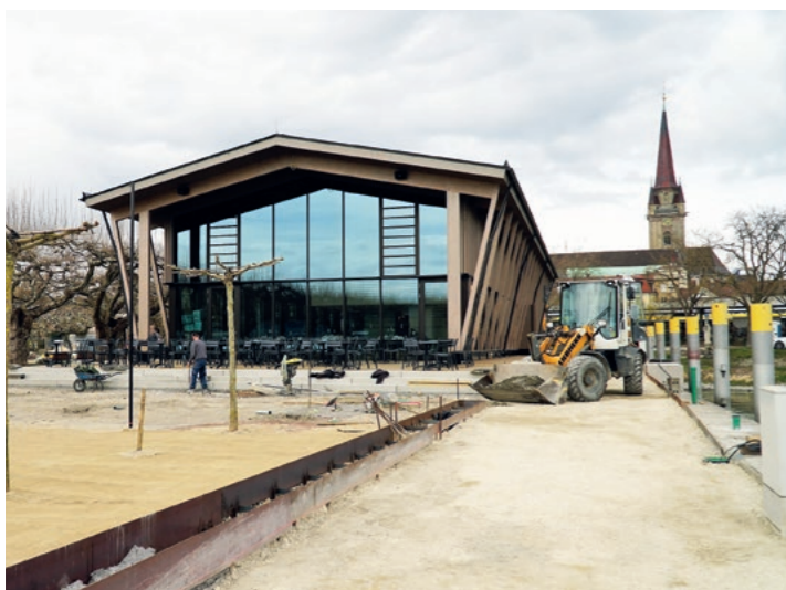
Vor dem neuerbauten Gastronomiegebäude entsteht ein großer Biergarten in unmittelbarer Nähe der Anlegestellen.
