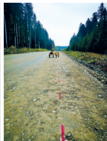
Exakte Markierung, hier auf einer Asphaltbaustelle.
