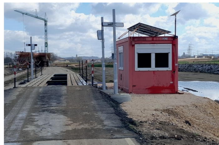
Auf der Großbaustelle in Erbach läuft die LKW-Waage autark – dank dem Strom aus vier PV-Modulen.
