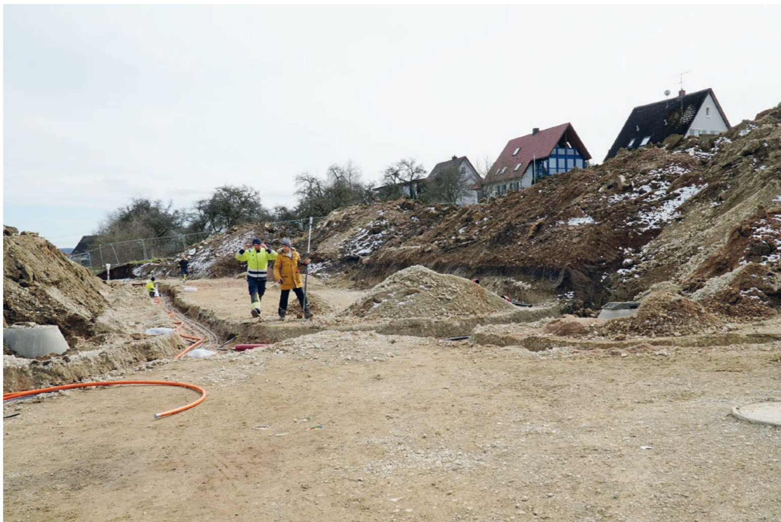
Im Bräunlinger Ortsteil Döggingen wird das Baugebiet Hofwiesen derzeit erweitert.
