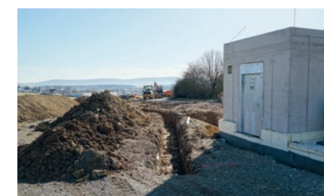
Das Gebäude des Tiefbrunnens, von dem die Druckwasserleitung abgeht.
