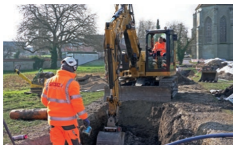
Aktuell wird im klösterlichen Kräutergarten gebaggert.
