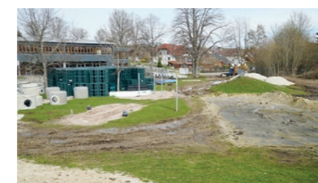
Diese Rigolenkästen sollen in ein künftiges Versickerungsbecken eingebaut werden.
