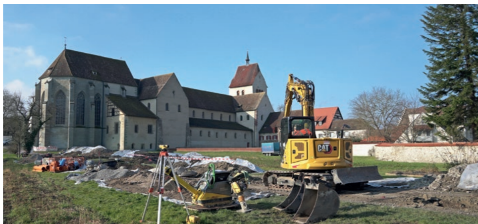
Kanalbau vor historischer Kulisse des Münsters St. Maria und Markus auf der Insel Reichenau.
