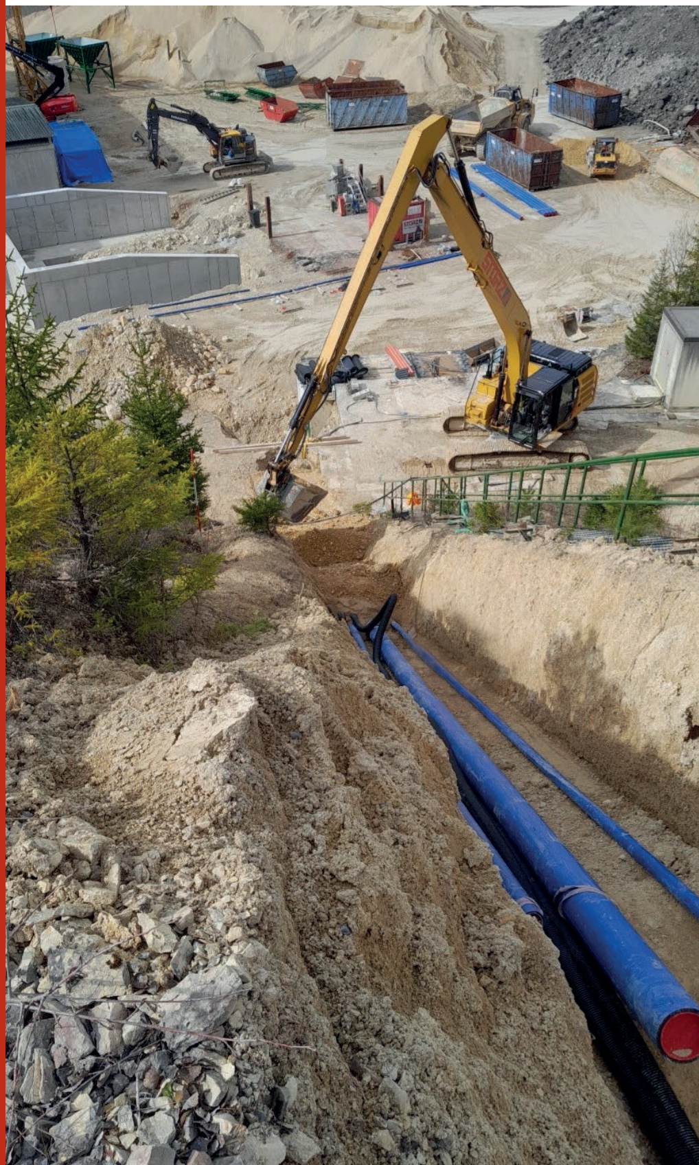
Die STORZ-Azubis verlegten Wasserleitungen und Stromkabel bei erheblichem Gefälle.
