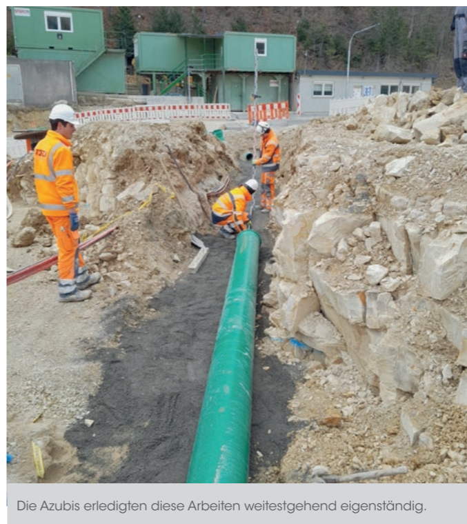
Vorbereitungen für den Einbau von Kanalrohren.
