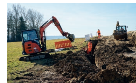
Neben der bereits eingebauten Wasserleitung entsteht der Graben für 120-KV-Kabel.
