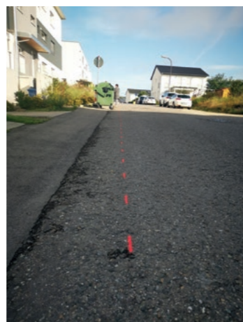
Markierung Asphaltabschnitt.
