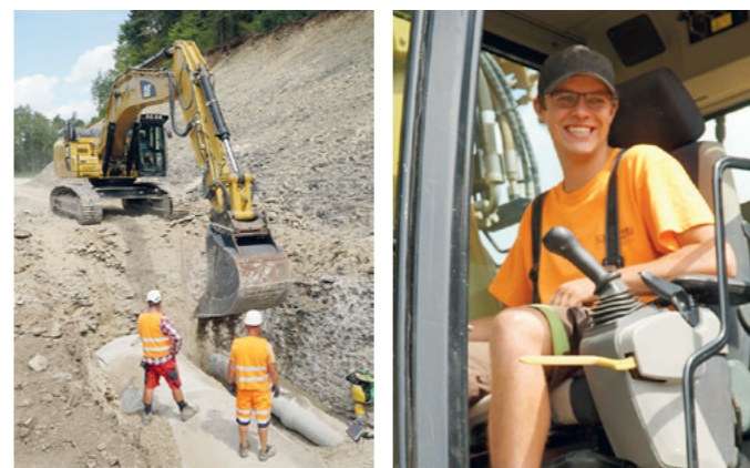
Kanalbau auf der Höhe: Im Graben Marko Olywa (l.) und Vasile Jijie. Rechtes Bild: Baugeräteführer Benjamin Fürderer.
