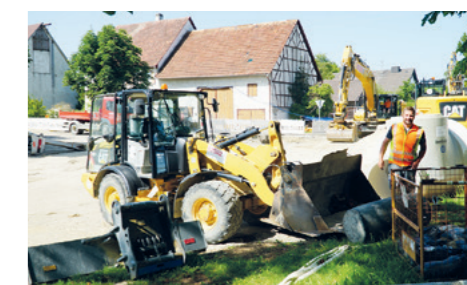
Vorarbeiter Benjamin Flöß. Ihm zu Füßen eine Absperrblase.
