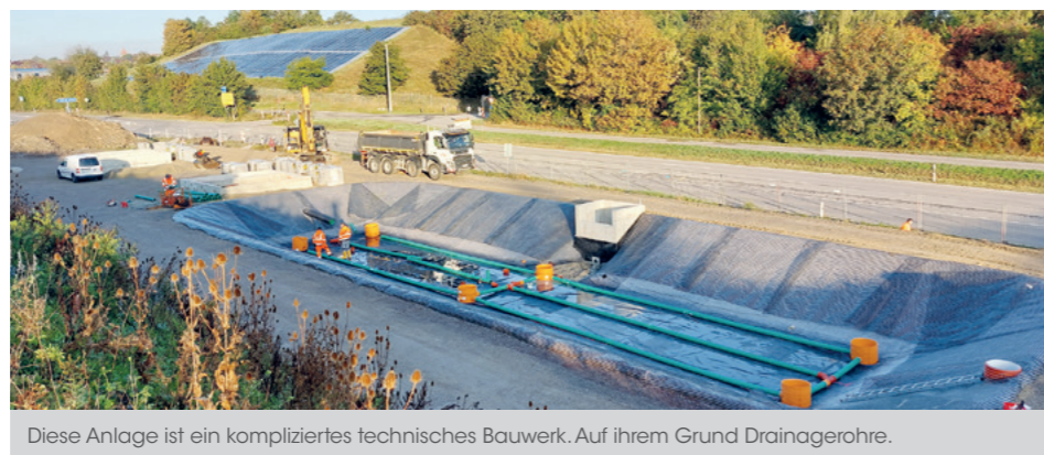
An der Anschluss-Stelle der A81 bei Oberndorf: links der Lagerplatz der Autobahnmeisterei, rechts das neue Klär- und Filterbecken.
