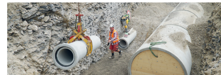
DN 2000-Stahlbetonrohre sollen das Regenwasser, DN 400-Rohre das Schmutzwasser abtransportieren.
