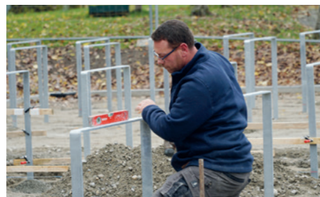
Polier Michael Kreuter bei der exakten Ausrichtung eines Abstellbügels.
