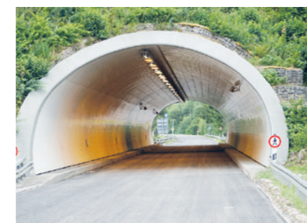
Beim Asphalt einbau im Schlossbergtunnel war keine Schiebetechnik nötig.
