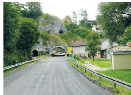
Der Schlossbergtunnel am Ortseingang von Veringenstadt.
