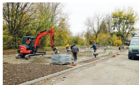
Auf der größten von insgesamt sechs neuen Stellflächen bauen die Kollegen von Schöppler Abstellbügel ein.
