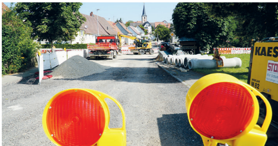
Die Stockacher Straße in Neuhausen ob Eck – auf mehrere hundert Meter Länge werden hier die Kanäle aufdimensioniert.
