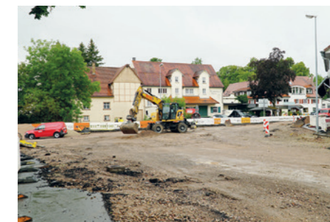
Das Dreieck Schaffhauser Straße / Dögginger Straße. Hier wird der Kreislauf entstehen.
