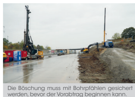
Das Baufeld für den künftigen Tunnel verläuft auf der alten Trasse der A81. Die Autobahn wurde provisorisch nach Süden verlegt. Rechts unten die Einrichtungsfäche mit den Bürocontainern.
