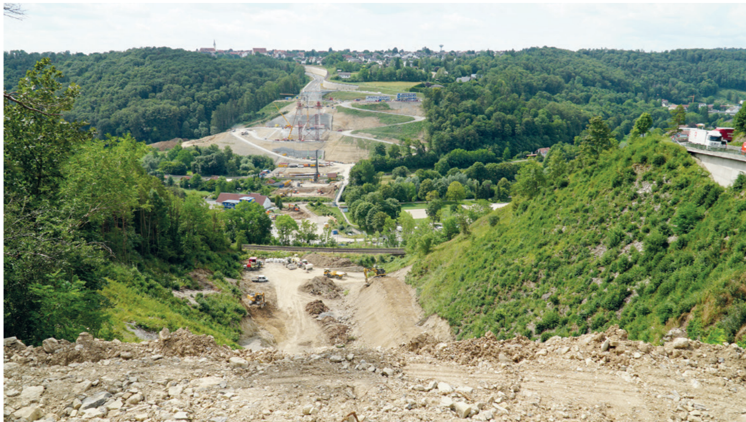
Die Baustelle der Neckartalbrücke bei Horb. Rechts am Steilhang bauen Storzianer die künftige Baustraße.
