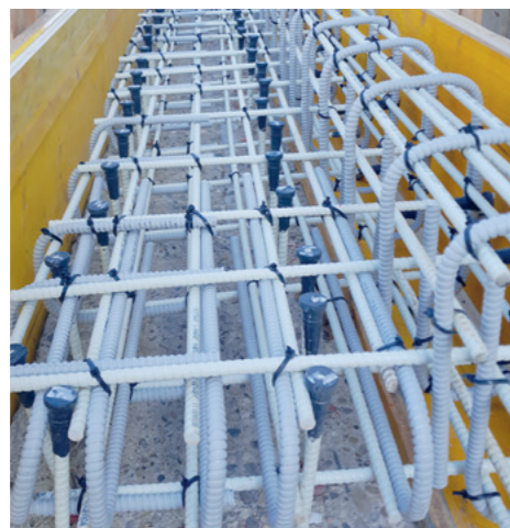
Kabelbinder sorgen für das nötige Geflecht.
