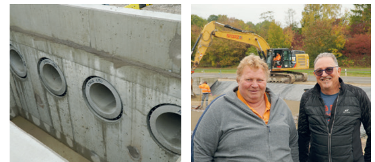
Links: In zwei großen Sammelschächten können sich grobe Partikel in einem ersten Schritt absetzen. Rechts: Polier Waldemar Schroth und Bauleiter Thomas Reckzeh (v.l.).
