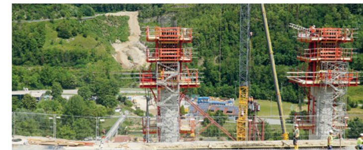
Blick vom Südufer auf die STORZ-Baustelle am jenseitigen Talhang.
