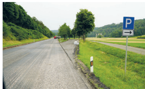
Auf 3,4 km Länge wird die B32 zwischen Veringendorf und Veringenstadt saniert.
