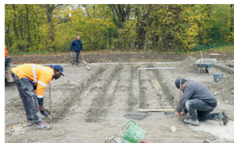
Für die Fundamente werden die Gräben ausgehoben.
