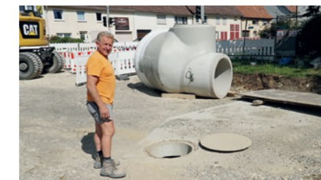
Polier Erwin Winze über dem eingebauten Sonderbauwerk.
