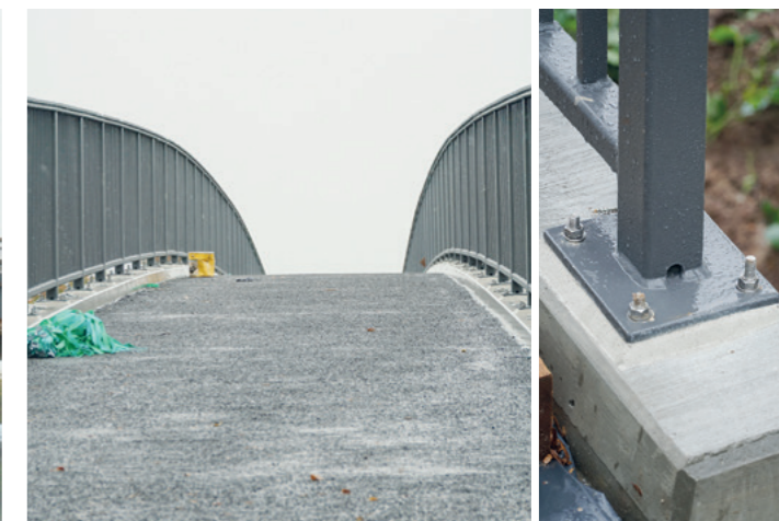
Die neuen Brückenkappen sollen bei gleichen Eigenschaften länger halten als solche in herkömmlicher Bauweise. Auf den Kappen ist das Geländer montiert.
