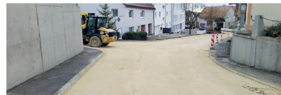
Ende November ist die Stockacher Straße provisorisch für den Winter vorbereitet.
