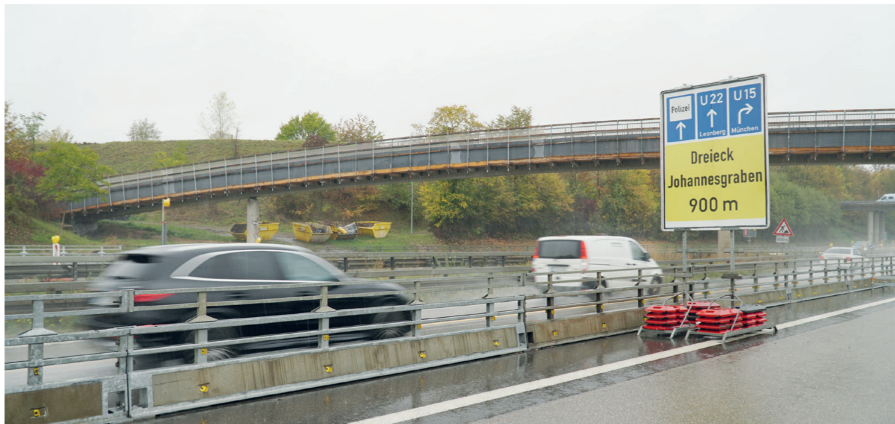
Die Fußgängerbrücke über die A831 bei Stuttgart-Vaihingen. Hier erprobt STORZ eine neue Betonbautechnik.
