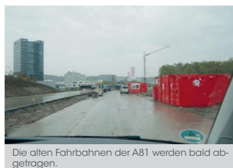
Das Baufeld für den künftigen Tunnel verläuft auf der alten Trasse der A81. Die Autobahn wurde provisorisch nach Süden verlegt. Rechts unten die Einrichtungsfäche mit den Bürocontainern.
