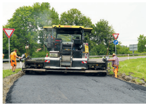
Die Zufahrten zur Bundesstraße bekommen neben einer neuen Decke auch neue Tragschichten.
