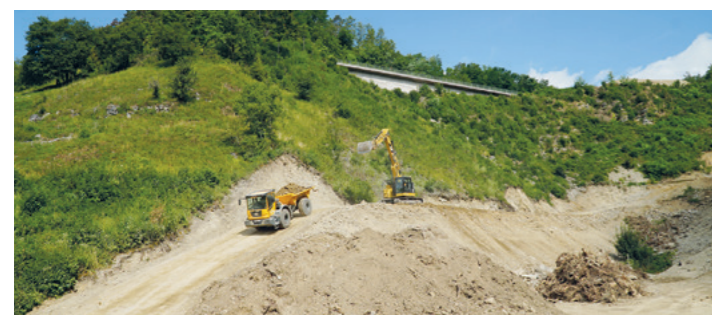
Schon bei der Anlage dieses ersten Aufstiegs muss man gute Nerven haben.
