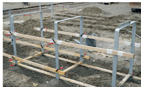
Gewusst wie - man hat sich einfache, aber wirkungsvolle Hilfsmittel gebaut als Abstandshalter.
