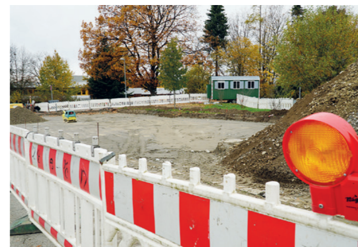
Das Areal für eine zweite Fahrrad-Abstellfläche ist bereits ausgekoffert.
