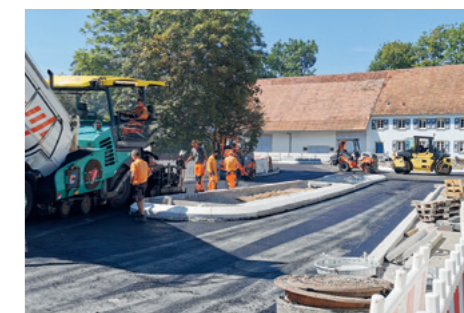
Die Kolonne um Asphalt-Polier Sven Dorn baut neue Fahrbahndecken ein.
