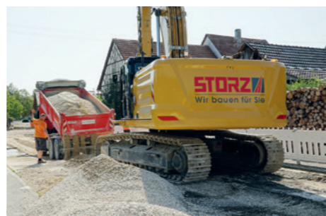
In der Talstraße sind die neuen Leitungen bereits eingebaut.
