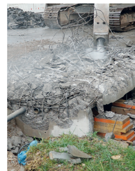
Entfernung der Flügelkappen an der Breg-Brücke.
