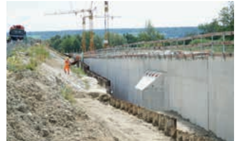
Die Seiten der Tunnelröhre werden hinterfüllt.
