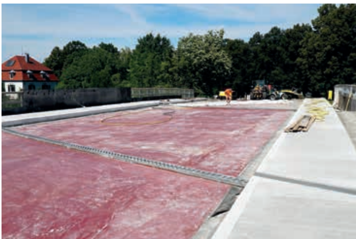
Drei unabhängige Brückenfelder bilden dieses Bauwerk.
