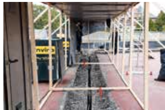
Die Übergangskonstruktionen der Brücke mussten ausgetauscht werden.
