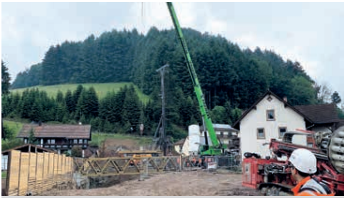
Mitte Juni wurde die Behelfsbrücke eingebaut, welche wieder eine direkte Verkehrsverbindung im Dorfczentrum ermöglicht.
