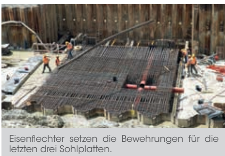
Drei Sohlplatten fehlen noch, dann ist der Untergrund fertiggestellt.
