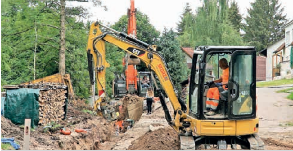
Eine klassische innerstädtische Kanalbaustelle: die Donaustraße in Pfohren.
