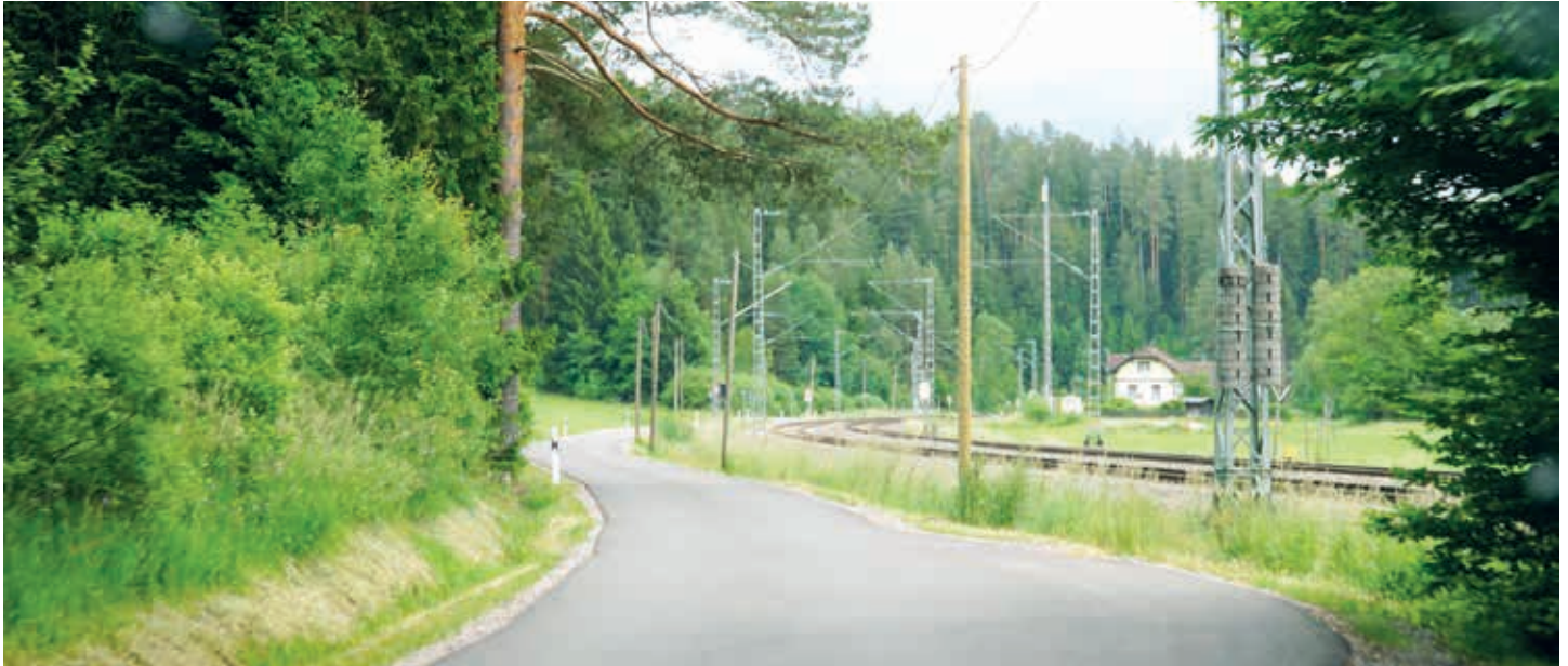
Schwarzwaldromantik im Groppertal – die sanierte Kreisstraße führt durch ein beliebtes Erholungsgebiet.
