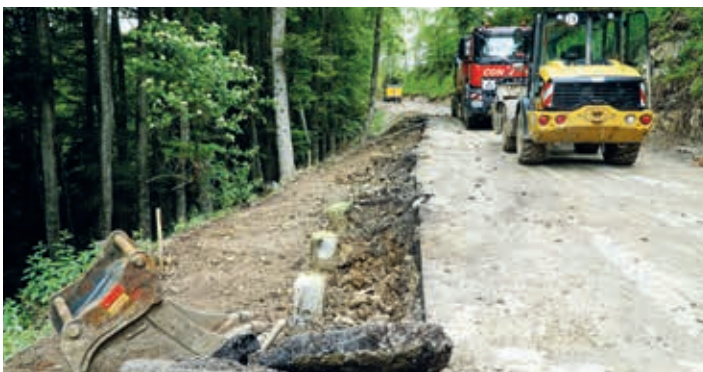
Solche neu gesetzten Bohrpfähle wird ein Kopfbalken später verbinden.
