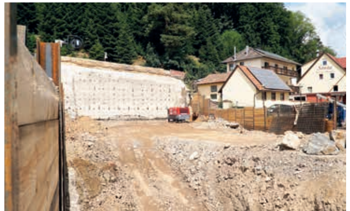
Der Aushub des Tunnels im Bereich der Portalwand wird besonders anspruchsvoll sein.
