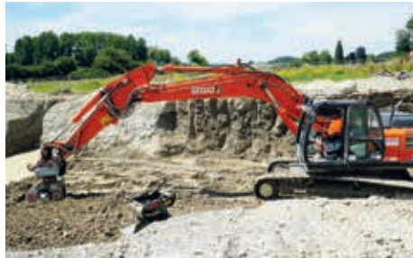
Im Westen der Baustelle wird ein Voreinschnitt ausgehoben.
