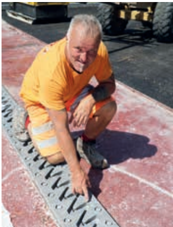
Polier Hannes Wappis und sein Team waren für die Sanierung zuständig.
