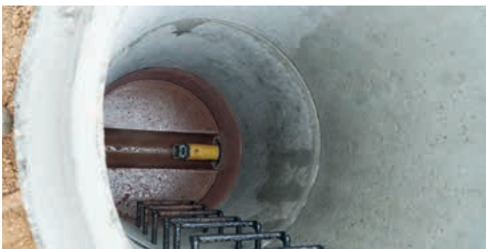
Der Kanal-Laser hilft, das exakte Gefälle zu erzielen.
