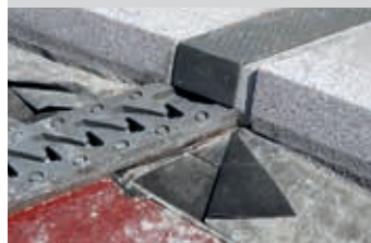
Die Übergangskonstruktionen der Brücke mussten ausgetauscht werden.
