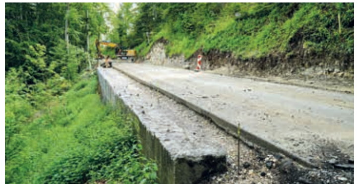
Im Voraushub wurden die alten Kopfbalken zunächst freigelegt.
