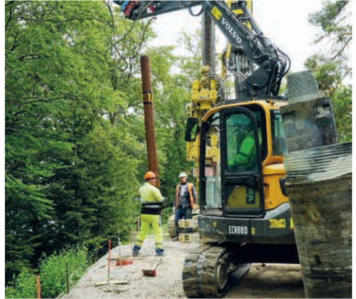
Eine Spezialfirma setzt die Bohrungen für die neue Hangsicherung.
