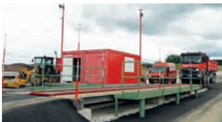
Die neu installierte LKW-Waage wird getestet.
