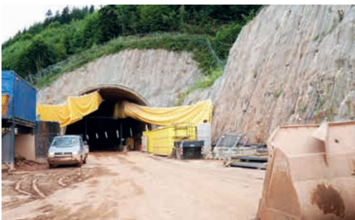
Rund 1.500 to Aushub pro Tag müssen von hier abgefahren werden.
