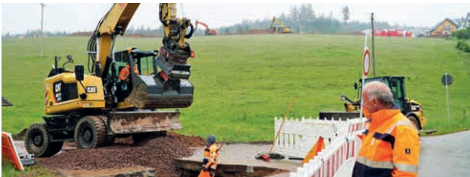
Polier Martin Messmer betreut den Kanalbau im unteren Bereich am Glashofweg.
