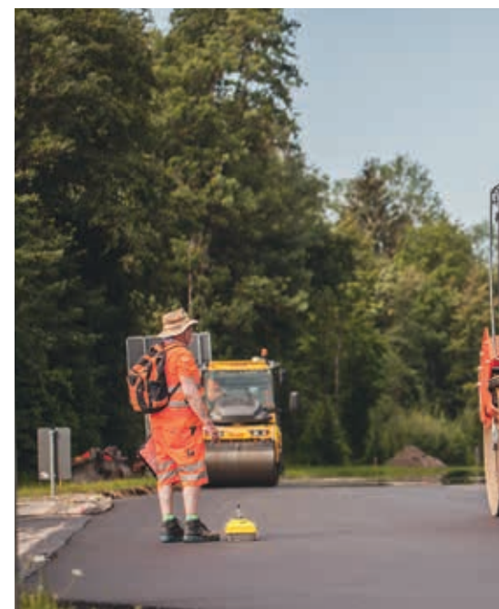
Kollegen aus dem Tuttlinger STORZ-Zentrallabor sowie aus dem Einbau mittels Troxlersonde.
