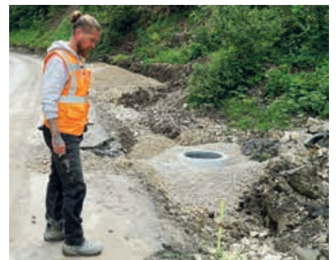
Die hangseitigen Entwässerungen längs der Straße sind bereits verlegt.
