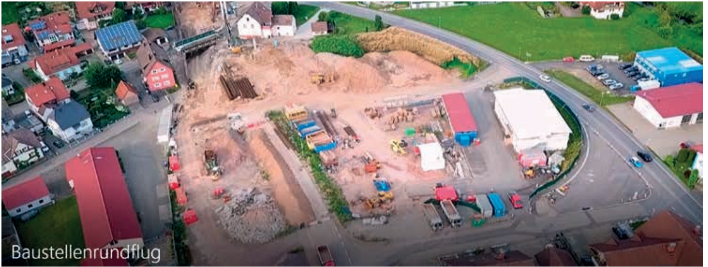
Das Baufeld West – hier entsteht ein Tunnel in offener Bauweise, an den sich ein Trogbauwerk anschließt.
