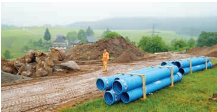
Hier werden getrennte Kanalsysteme für Regen- und für Schmutzwasser verlegt.
