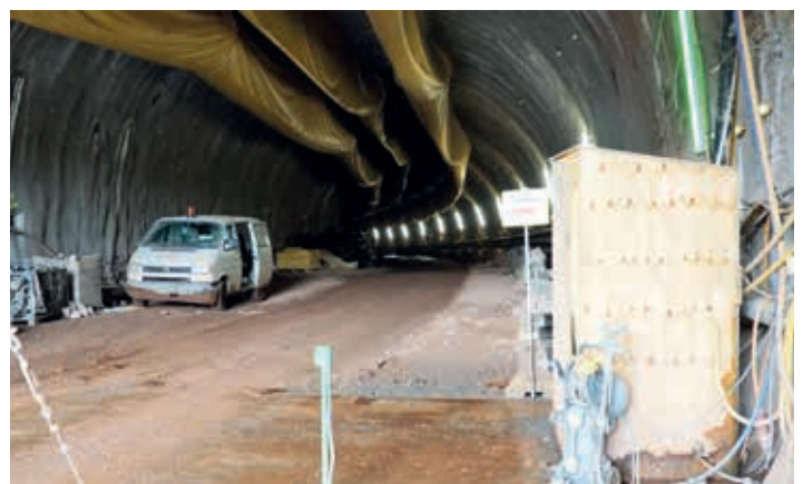
Über die Hälfte des Tunnelvortriebs ist seit Mitte Juni geschafft.
