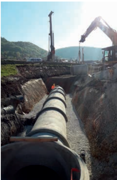
Der neue Hauptkanal auf dem Firmengelände.
