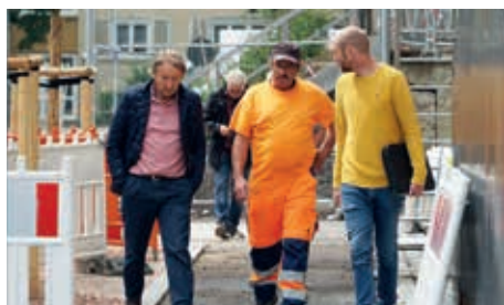
Die Begehung der Baustelle gehört nach der Besprechung dazu.
