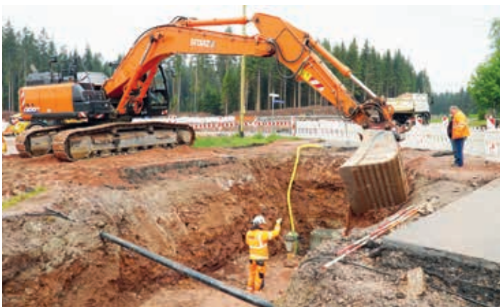
Die Entwässerung des neuen Gewerbegebietes ist ein wichtiges Thema. Im Graben Facharbeiter Viktor Meier.
