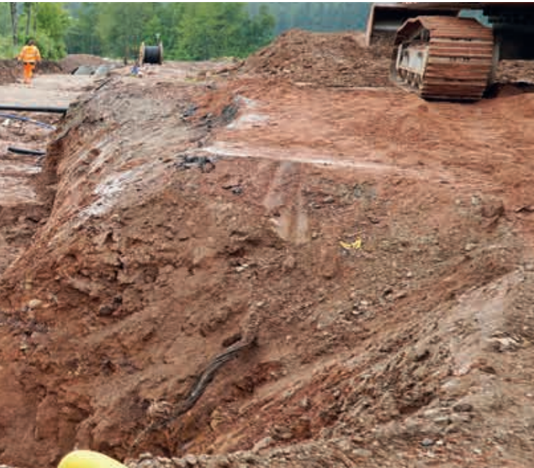
500 m Entwässerungskanal wurden hier eingebaut.
