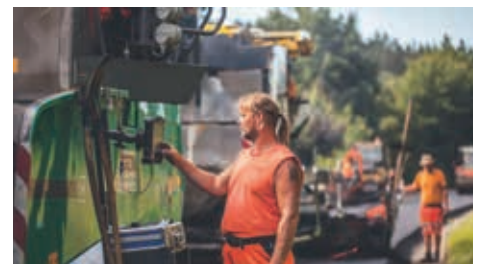
Die dynamische Logistiksteuerung vernetzte Produktionsanlage, Transportfahrzeuge und Einbaumaschinen.
