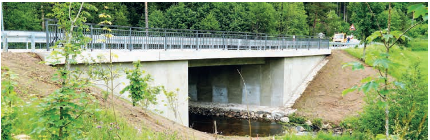
Die Stockburg-Brücke über die junge Brigach hat die STORZ-Bauwerkinstandsetzung saniert.
