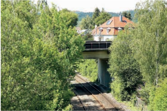
Die Konstanzer Brücke in Radolfzell – ein Standardbauwerk aus den siebziger Jahren.
