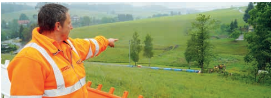
Diese Feuchtwiese müssen die Storzianer beim Kanalbau umgehen. Betreten verboten! Das gilt auch für Polier Michael Kollath.
