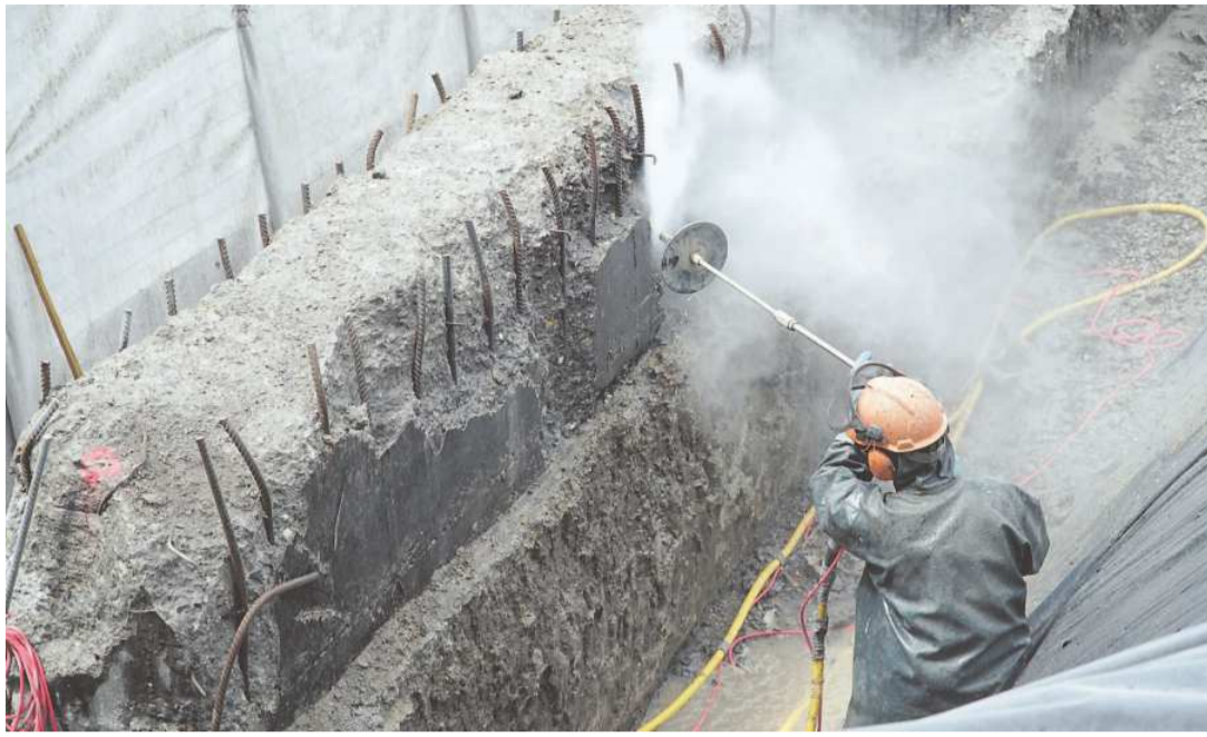
Ein Höchstdruckstrahl mit 2000 bar Druck – mit dieser Technik wird der Jahrzehnte alte Beton der Pfahlkopfballen freigelegt, ohne die Stahlbewehrung zu verletzen. Auf den alten Gründungen soll auch die neue Brücke ruhen. Fotos: Joachim Mahrholdt
