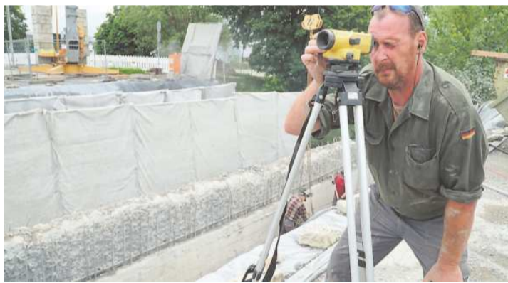
Polier Gerd Lejsek von der Baufirma Storz überprüft die Höhenlage der Pfahlkopfballen an der Neckarbrücke.
