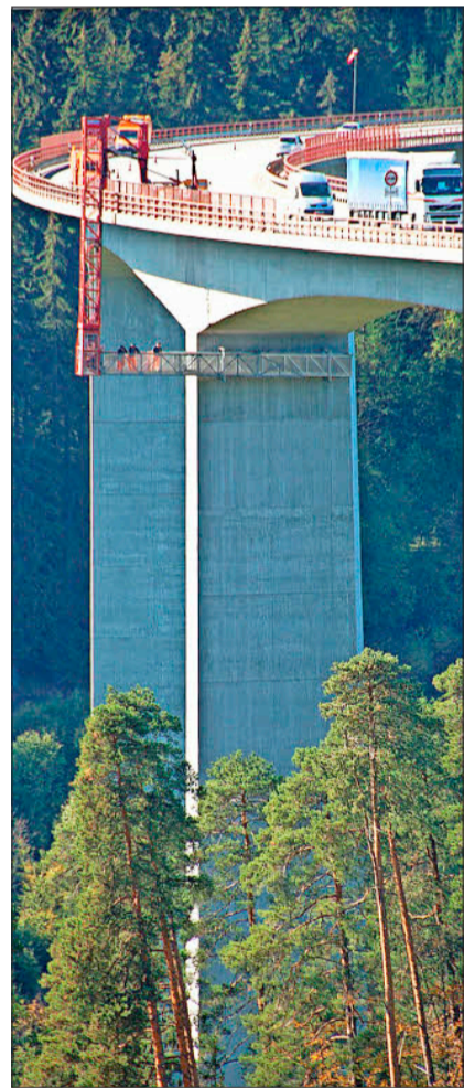
Untersichtprüfung an der Gutachtalbrücke im Jahr 2011. FOTO: STELLMACH
