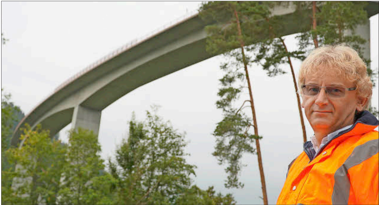
Die Gutachtalbrücke bei Neustadt ist in gutem Zustand. Bauwerkprüfingenieur Bernd Weimer sieht Kontrollbedarf weniger bei den Großbrücken, sondern eher bei den kleinen Kommunalbauwerken. FOTOS: JOACHIM MAHRHOLDT
