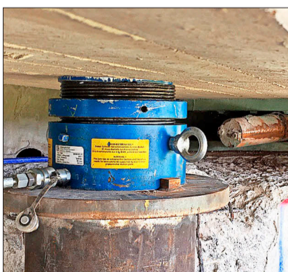
Auch Brücken können Lagerschäden aufweisen – dann werden die Elastomerkonstruktionen oder Rollen ersetzt. Mit hydraulischen Pressen wird die Brücke angehoben.
