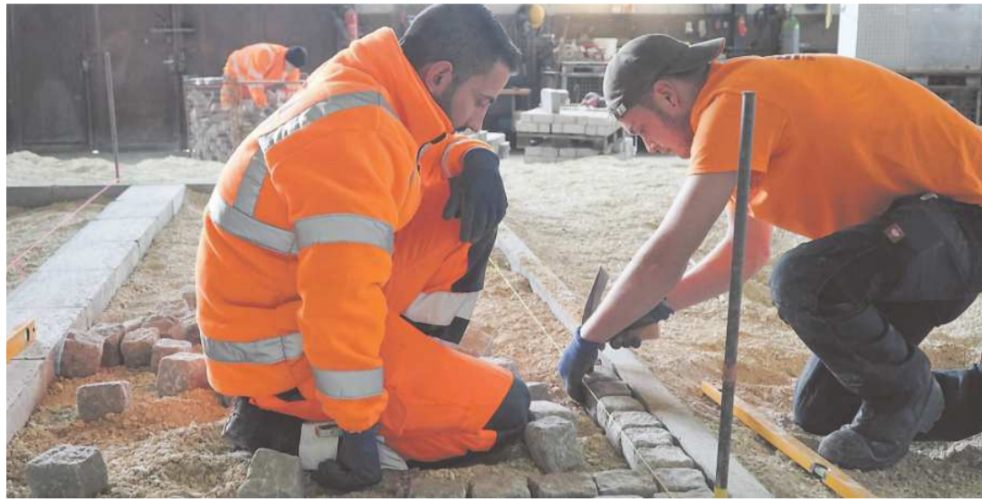
Richtig pflastern will gelernt sein - Mirkan Unur (links) und Jannik Braun üben es. Eine Fertigkeit, die sie bei der Anlage von Gehwegen und Hofeinfahrten brauchen werden. Foto: Joachim Mahrholdt
