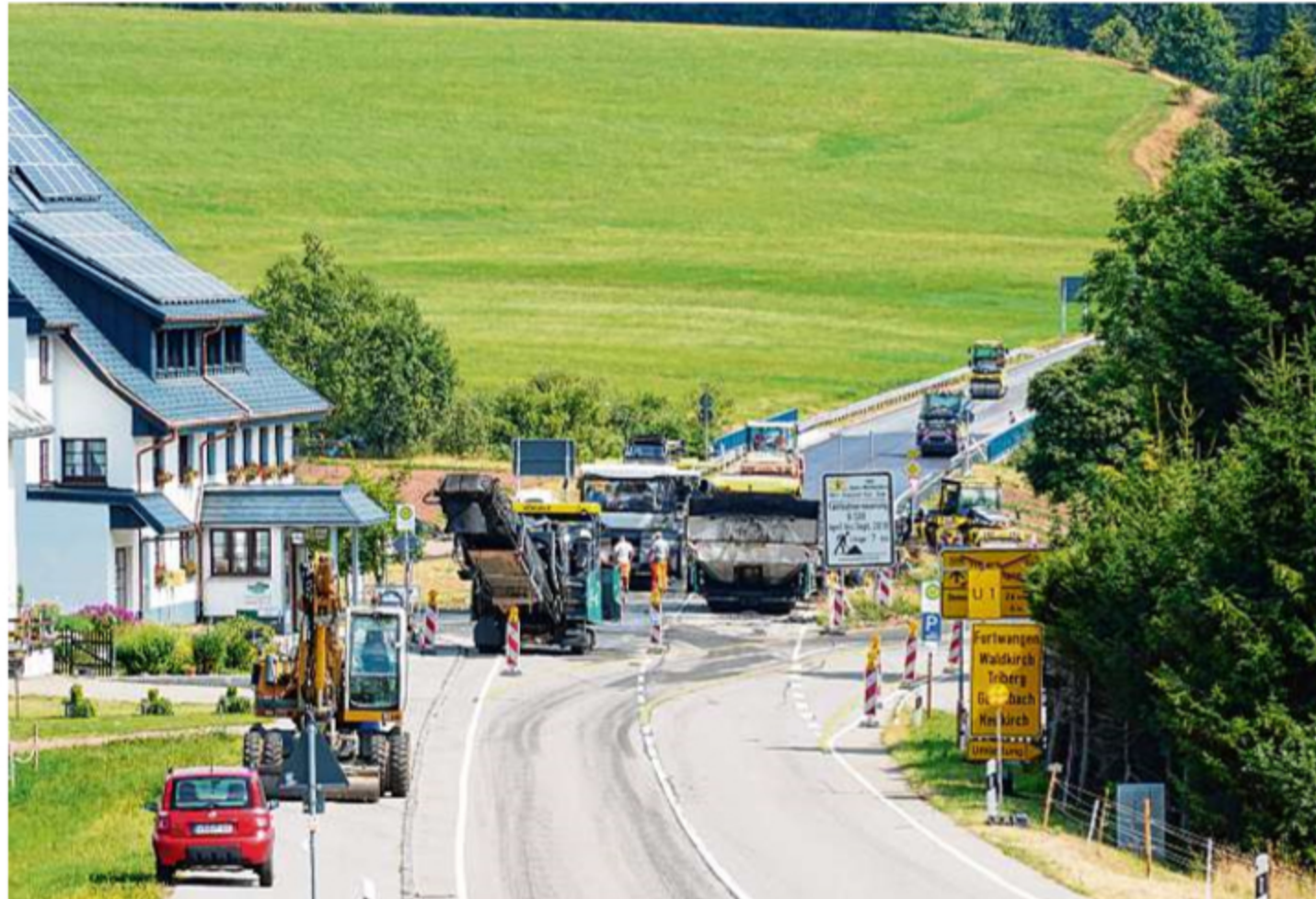
In nur drei Tagen haben die Straßenbauer knapp sieben Kilometer Deckschicht an der B500 zwischen Furtwangen und Kalte Herberge eingebaut – und das bei größter Hitze.
