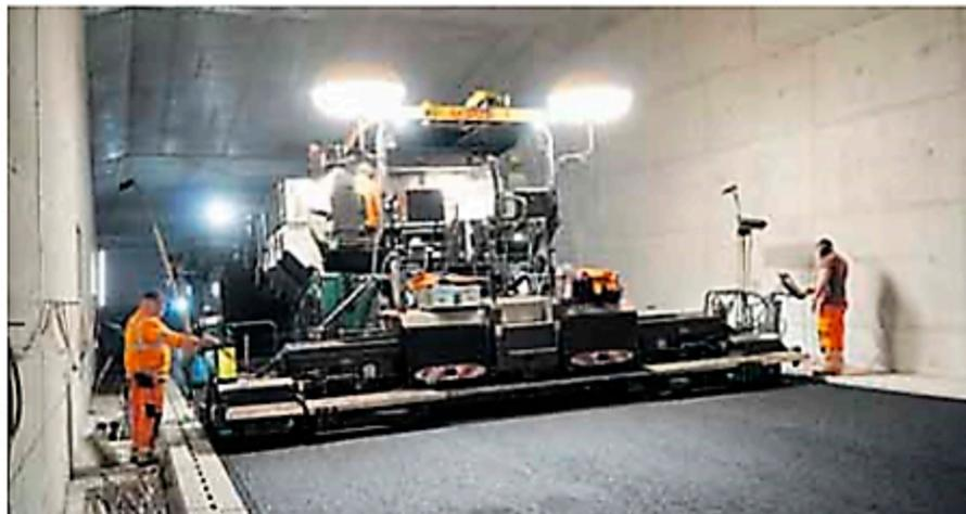
Arbeit unter schwierigen Bedingungen: der Asphaltsteinbau im Tunnel.
