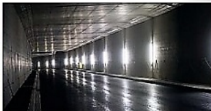
Die Bohrstrecke des Doppeltores. (Quelle: Saur/Infra)
