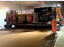
Der Dribba-Druckbohrer erledigt die Spezialarbeiten beim Tunnelbau. (Quelle: Saur)
