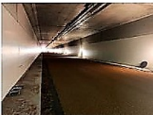
Die volle Deckhöhe aus Asphalt soll später zur Verkehrschemie beitragen. (Quelle: Saur)
